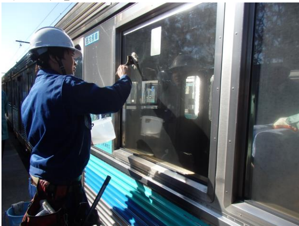
グローバル-1（酸性液）5倍希釈で開始 ハケ塗り後ガラス用パットで液を延ばして、汚れを浮き上がらせていく
