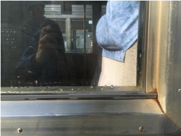
左側窓のアップ状態
