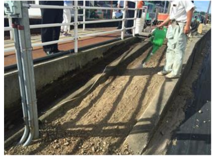
②施工前の処理(現場整地)
