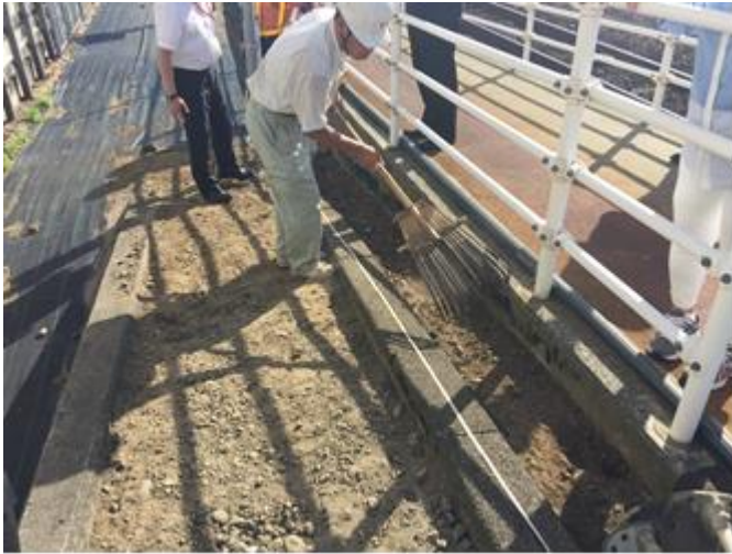
①施工前の処理(現場整地)
