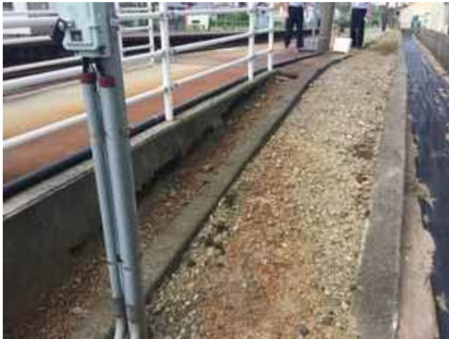
施工前の現場
