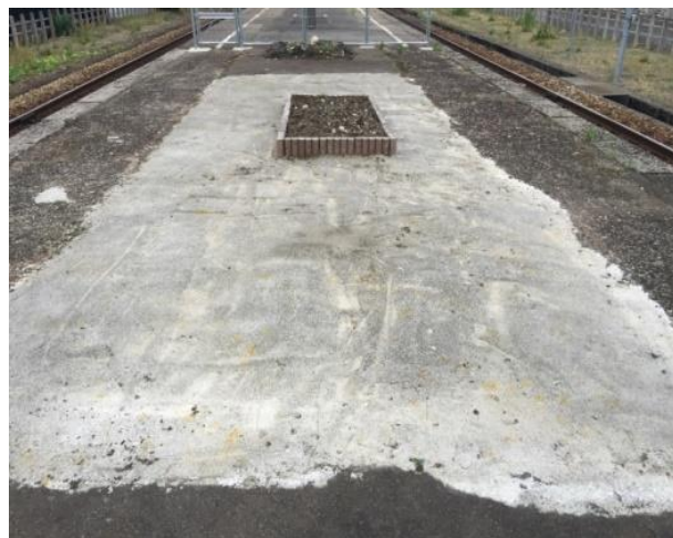
「駅」プラットフォームの花壇周囲に施工
